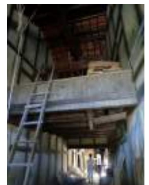
写真3：対象敷地①の使われていない倉庫
